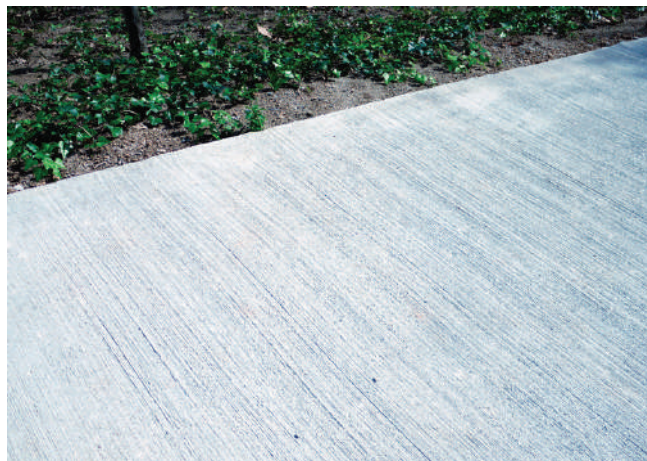
Dallage béton finition balayé
